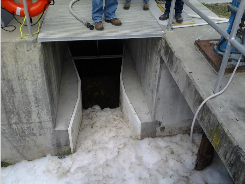
Effluent Flume
