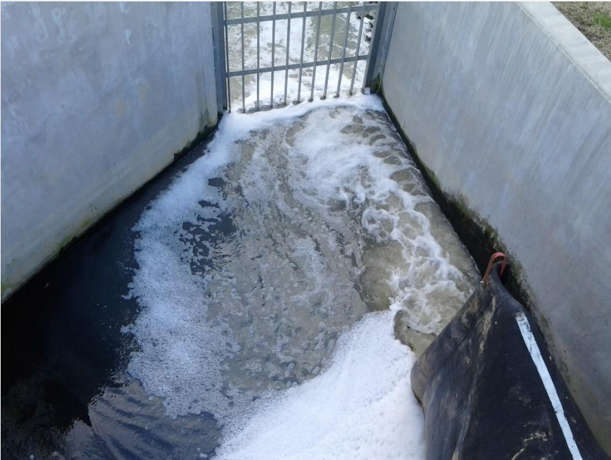
Effluent Grate
